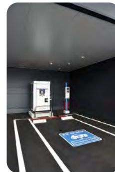
屋根付き半屋内空間に最大出力90kWの急速充電器を設置
